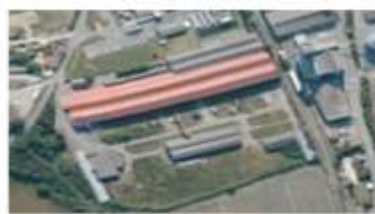
Sito Logistico Beaurepaire, Francia
